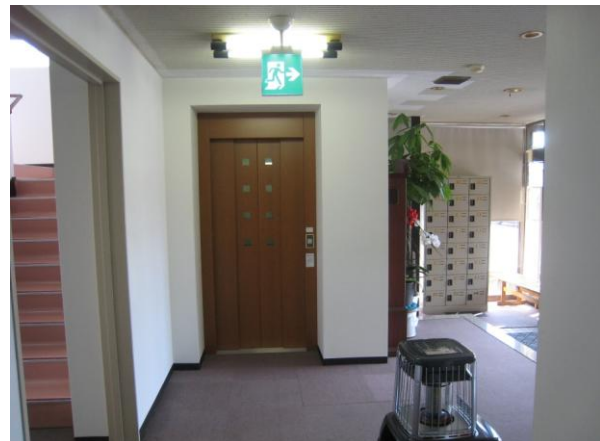
エレベーター
